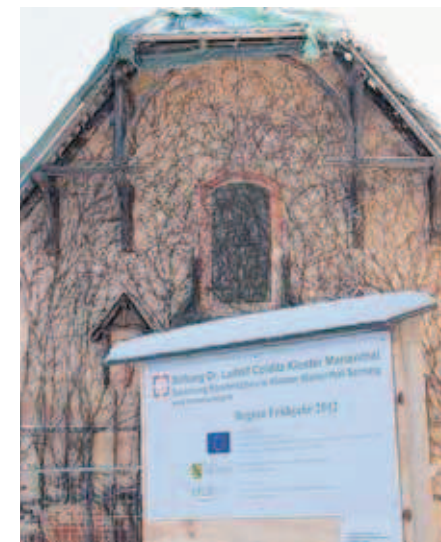
Über das Bauvorhaben wird auf einer Informationstafel informiert.
