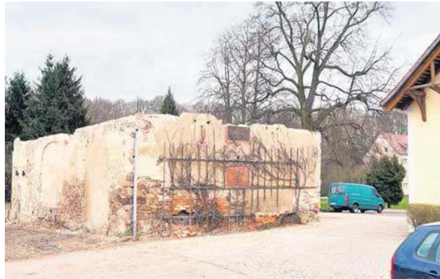
Die Klosterscheune in Sornzig: Die Abrissarbeiten sind beendet. Nach der Submission am 10. April sollen die Arbeiten für den Rohbau vergeben werden. Foto: Sven Bartsch
