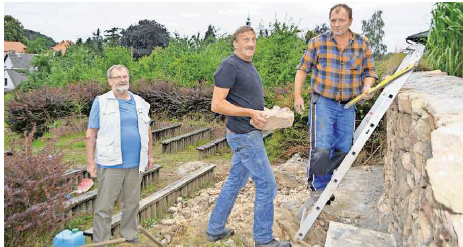
Wolfgang Hanns hier mit Maurer Reiner Siebert und seinem Kollegen Uwe Böttcher (von links), die gerade an der historischen Klostermauer arbeiten.
